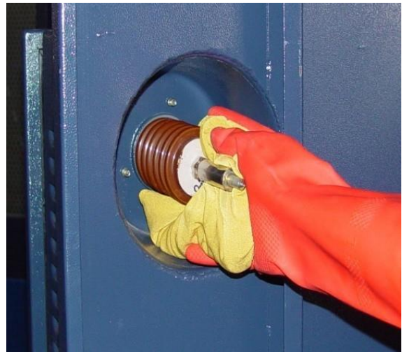
Kapakta ki seramiz izolatörü temizleyin
